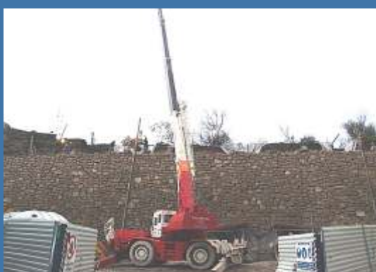
OBRAS DE CONSOLIDAÇÃO DA MURALHA DO CAVALEIRO
